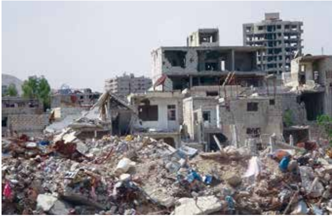
Viele Außenbezirke der syrischen Hauptstadt Damaskus sind völlig zerstört.
